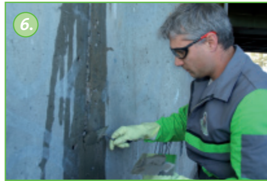
6. Sulje halkeama sen kulkusuunnassa KÖSTER KB-Fix 5 materiaalilla. Halkeaman sulkeminen ehkäisee injektointimateriaalin enneaikaista valumista ulos halkeamasta injektoinnin aikana. Kovettumisaika on n. 5 minuuttia riippuen ympäröivästä lämpötilasta ja ilmankosteudesta.
