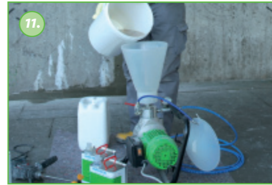
11. Valmistelee KÖSTER pumppu injektointityötä varten kuten ohjekirjassa on suositeltu. Täytä sekoitettu hartsi pumpun materiaalisäiliöön. Valmiiksi sekoitettu materiaali tulee käyttää käyttöajan puitteissa.
