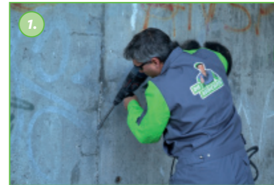
1. Avaa halkeama V-muotoon 1 cm–2 cm syvälle ja poista irtonaiset osat sekä pöly harjalla.
