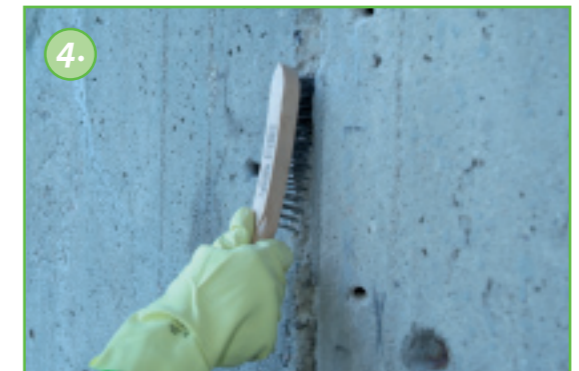
4. Putsaa halkeama käyttäen teräsharjaa.
