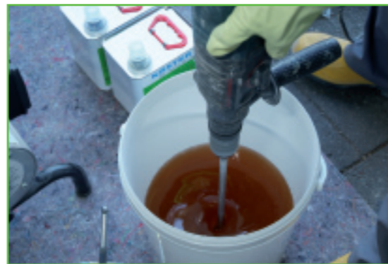
Käytetään sopivaa sekoitinta esim. KÖSTER hartsin sekoitustyökalua yhdistelmänä hitaasti pyörivän mekaanisen sekoittimen kanssa sekoitetaan molemmat komponentit. Komponentteja sekoitetaan kunnes seos on homogeeninen.
