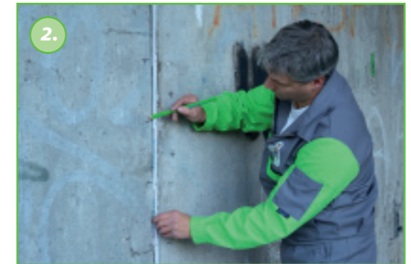
2. Merkkää paikat joihin porausreiät porataan. Porausreiät sijoitetaan pitkin halkeaman suuntaa molemmin puolin n. 10 cm–15 cm etäisyyksin toisistaan.
